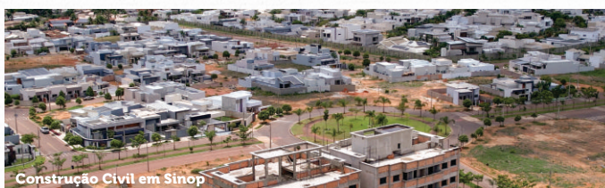
Construção Civil em Sinop
