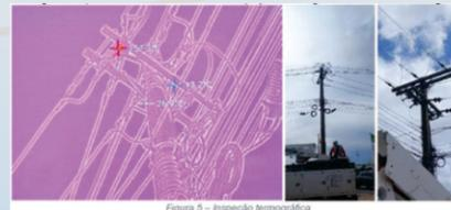
Figura 5 – Inspeção termográfica
